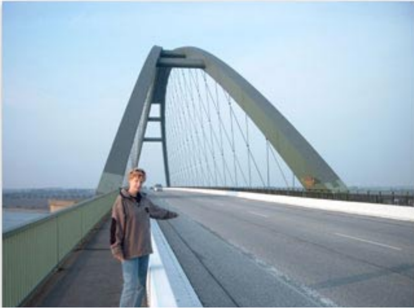
1. Die Fehmarnsundbrücke, 1963 erbaut und 963 m lang. Von der Mitte der Brücke bis zur 1. Abfahrt sind es noch 2,8 km.
